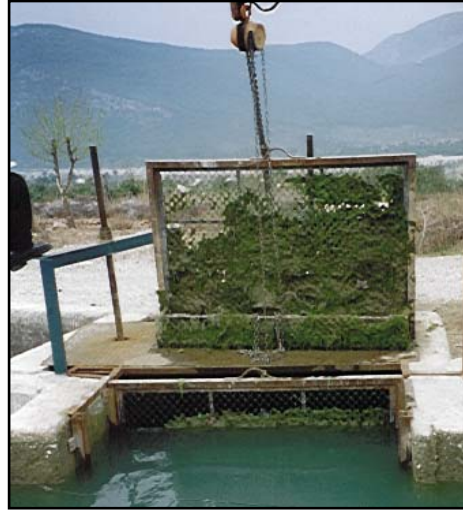
Şekil 2.16.İpliksi Alglerin Izgaralarda Neden Olduğu Tıkanmalar
