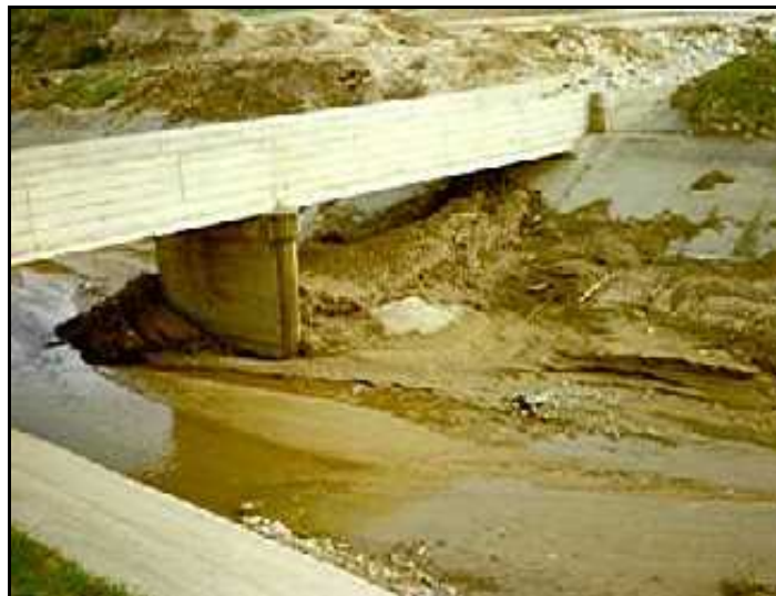
Şekil 6.24.Sulama Kanalına, Üst Sel Geçidi Çevresinden Tortu Girişi
