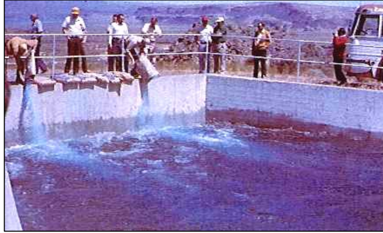
Şekil 7.17. Sulama Kanallarında Dökme Yöntemi ile Göztaşı Uygulamaları (208)
