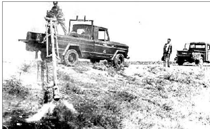
Şekil 5.26.DSİ'de Alev Makinesi ile Yapılan Yakma Uygulamaları
