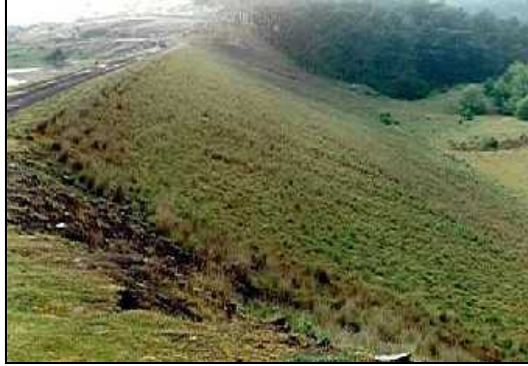
Şekil 6.31.Baraj Gövdesi Hava Tarafında Bitkisel Kaplama Uygulaması
