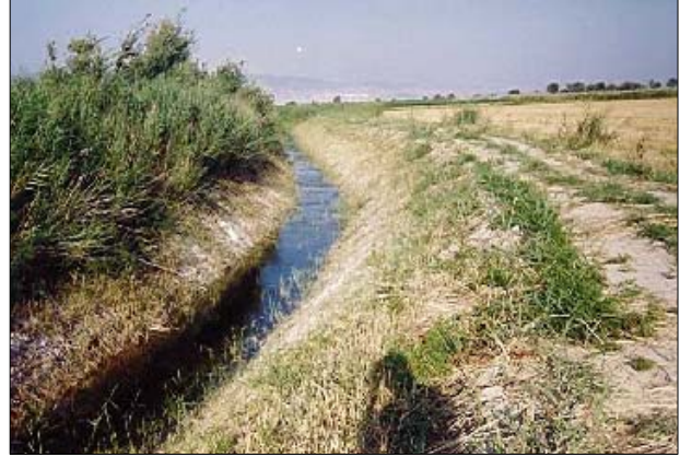
Şekil 5.18.Bıçme Kepçesi Takılı Uzayıp Kısalabilen Kolları Bulunan (teloskopik boom) Makine ile Bıçılmış Boşaltma Kanalı
